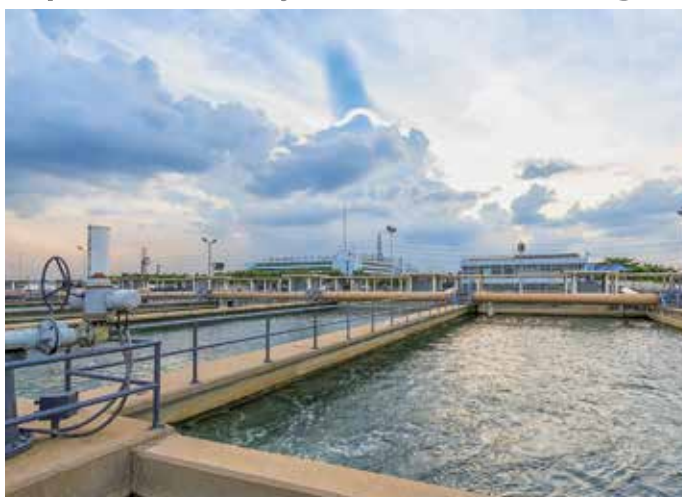
Depuradoras - Estações de tratamento de água
